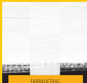
FARBAUFTRAG MIT PINSEL
